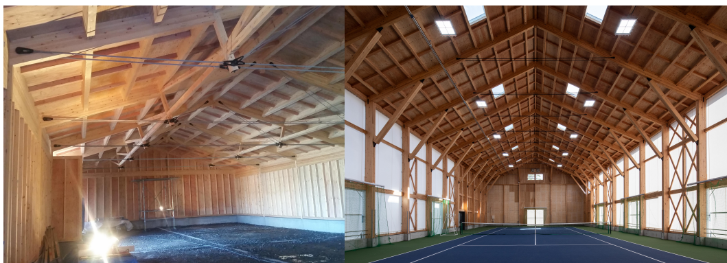
★ATAハイブリッド構法の木造倉庫と木造テニスコート
